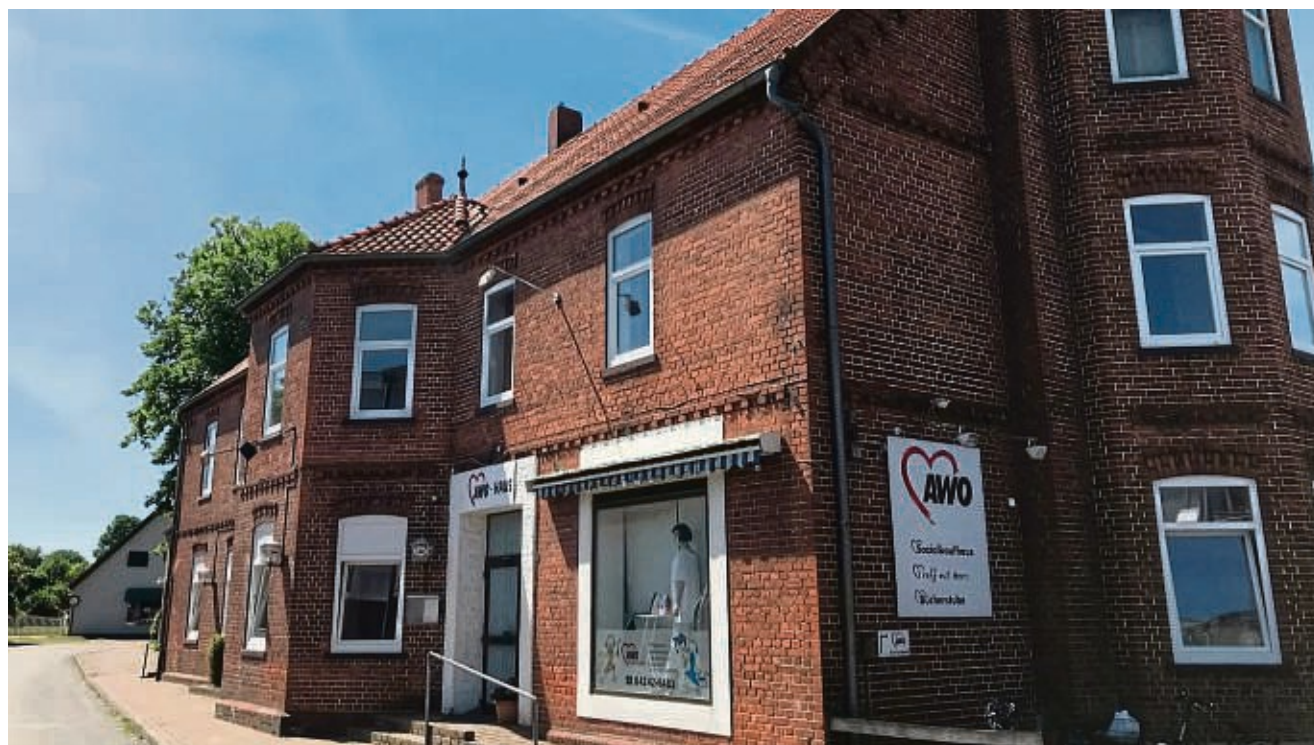
Dem Awo-Haus an der Glockenstraße in Barrien steht ein größerer Umbau bevor. Im Erdgeschoss will der Kreisverband eine Tagespflege einrichten. Die Sozialstation – das ist die ambulante Pflege – zieht eine Etage höher. Der Rest des Obergeschosses wird Büro und Verwaltung.
