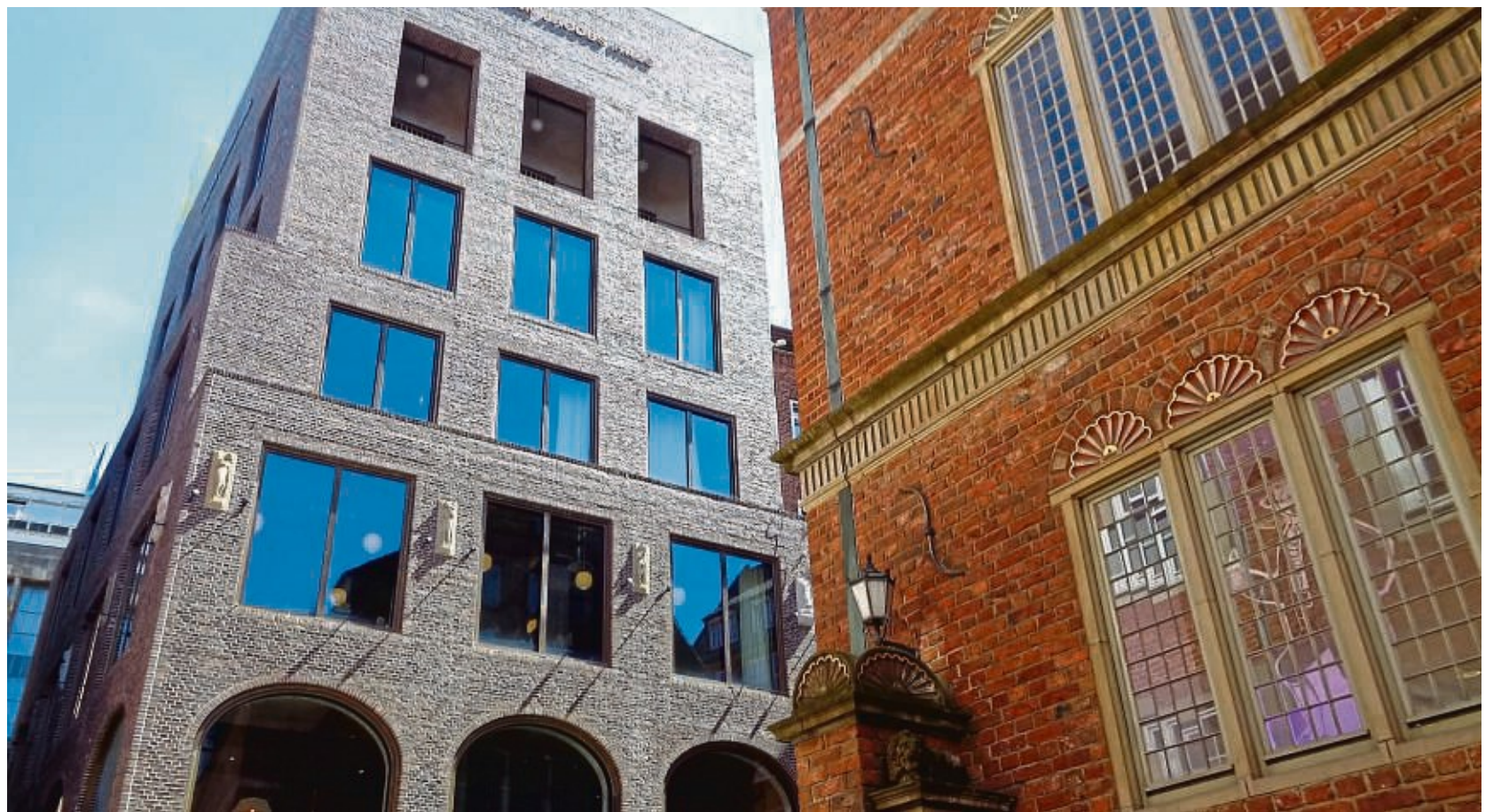
Die Verbindung von der Oberstraße zur Stadtwaage und damit das Tor zum geplanten „Balge-Quartier“: das „Johann-Jacobs-Haus“ in der Bremer Innenstadt, neu errichtet am Stammsitz der Kaffee-Dynastie. FOTO: KUZAJ
