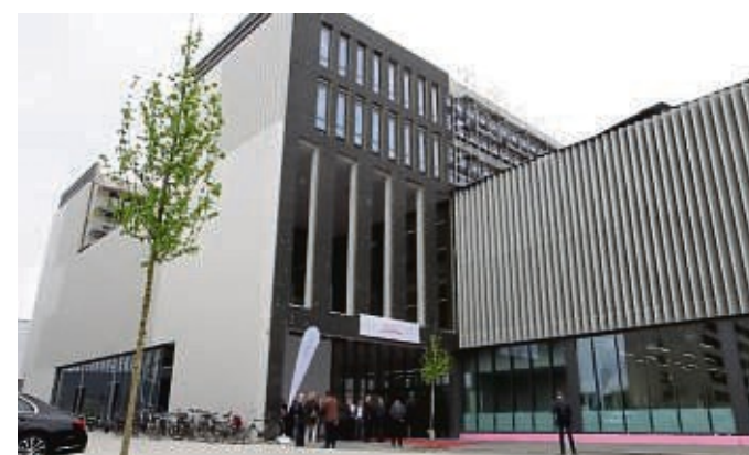
Im Technologiezentrum „Ecomat“ wird eine Testinfrastruktur für tiefkalten Wasserstoff aufgebaut. FOTO: KOLLER
