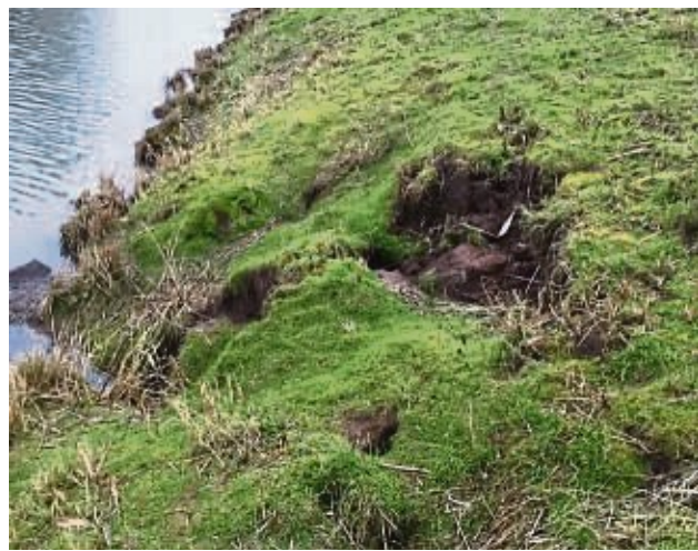
Diese Abbrüche an einem Entwässerungsgraben werden Nutrias zugeschrieben.
