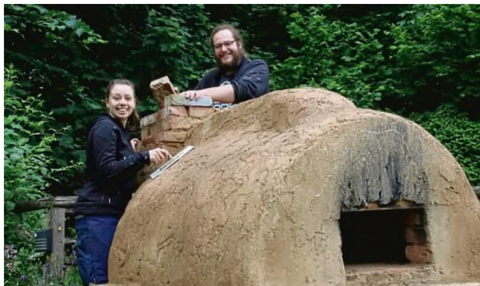
Vielseitige Talente: Die zweite Lehmochicht fehlt noch, aber der Probetrieb ist für die Bauherren Rainer und Janina schon mal sehr vielversprechend verlaufen.
