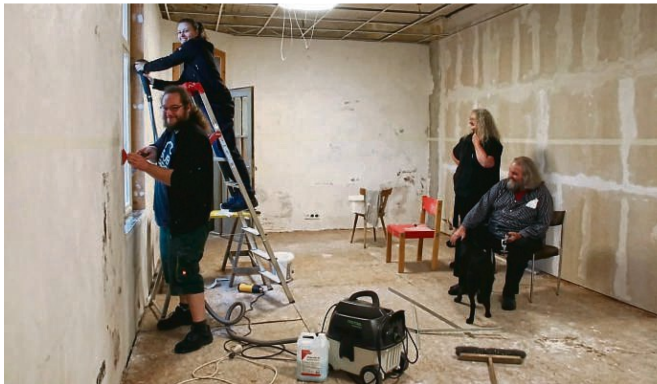
Der Billardraum ist für die Renovierer Rainer Andrzejewski und Janina Habenicht das bislang größte Projekt. Bernhard Nüttgens und Astrid Andrzejewski (r.) sind gespannt, wie es später aussehen wird.
